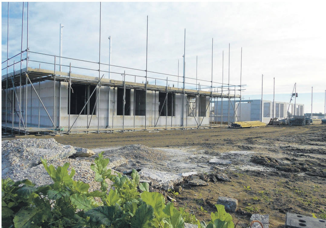
▲ Work in Progress, voortgang nieuwe Hoge Veer.
